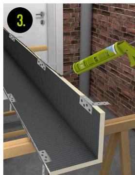
3. codex SK 100 1-K Hybrid-Montagekleber auf Stoßkanten aufbringen
