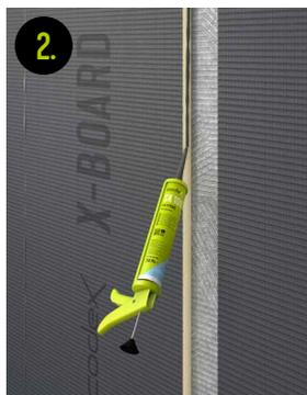
2. Stoßkanten mit dem 1-K Hybrid-Montagekleber SK 100 auftragen.
