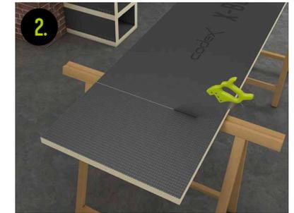
codex X-Board Bauplatten sind einfach auf entsprechendes Maß zuzuschneiden
