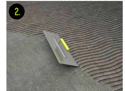
2. Auf die Fläche codex Dünnbettmörtel (S1) aufbringen. Bei Bedarf zuvor Grundieren.
