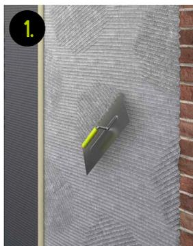
1. Mit einer Zahnkelle den codex Dünnbettmörtel gleichmäßig auftragen
