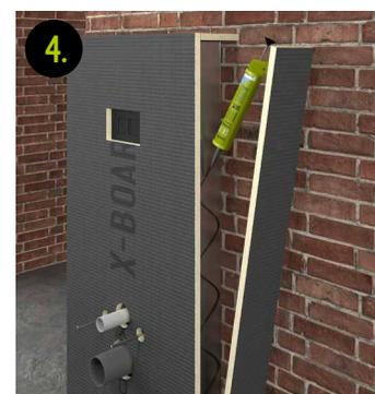
4. Mit Hybrid- und Montagekleber codex SK 100 die zugeschnittenen schmalen X-Board Platten oben und seitlich verkleben
