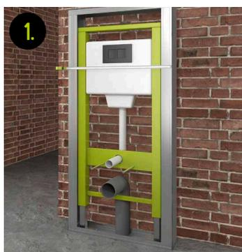
1. Nachdem das Vorwandelement und Ständerwerk aufgebaut ist, Maß nehmen für passende X-Board Bauplatten
