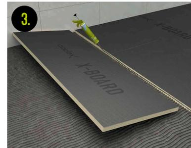
3. codex X-Board Platten in den Dünnbettmörtel einlegen. Stoßkanten mit codex SK 100 Hybrid-Montagekleber verkleben.
