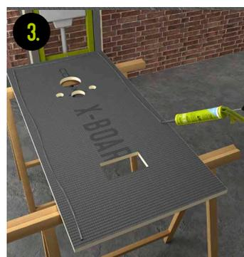
3. codex X-Board Bauplatte mit codex SK 100 auf Ständerwerk befestigen
