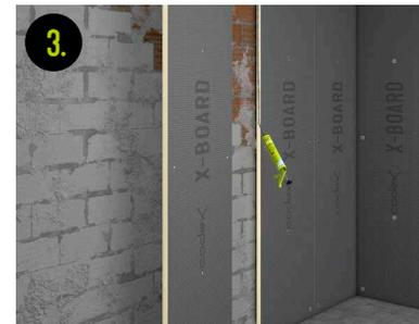
Stoßkanten der codex X-Board Bauplatten mit 1-K Hybrid-Montagekleber codex SK 100 verkleben
