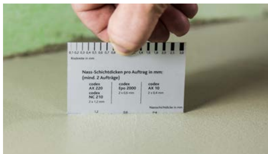
2. Kontaktschicht aufziehen und anschließend erste Schicht mit 4 mm Zahnung aufkämmen und glatt umlegen. Nach Trocknung zweite Schicht auftragen.
