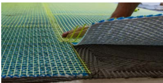
3. Matten stoßversetzt verlegen.
