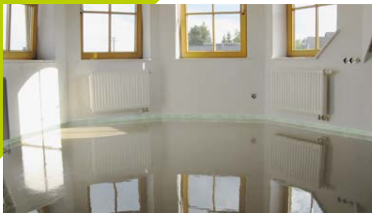
Selbstverlaufende Bodenspachtelmasse mit breitem Schichtdickenbereich und optimalen Fließigenschaften, ideal auch für den schnellen Baufortschritt besonders in der Sanierung.
