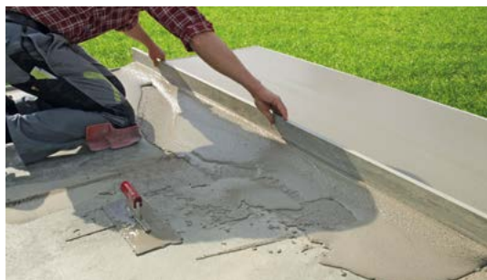
Gefälle bis max. 4% mit Richtlatte herstellen.
