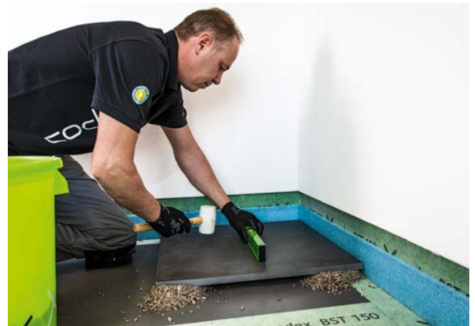
Je nach Plattendicke/-größe Belag auf 4 – 6 Batzen verlegen.
