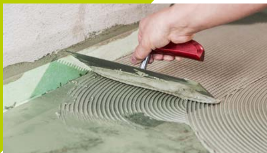
1. codex AX 230 in den Ecken vorlegen und Formteile einlegen.
