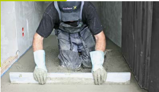
Abziehen des Estriches auf den Lehren.
