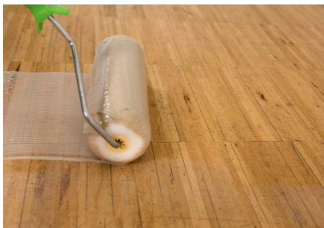
codex X-Change-Fixierung auf vorbereiteten Untergrund aufbringen.
