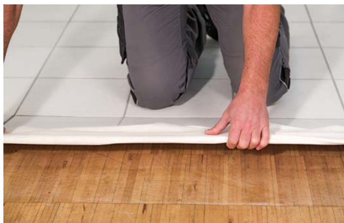
Zugeschnittene codex X-Change-Vliese in die nasse Fixierung einbringen. Nach 24 h Belag aufbringen und fachgerecht Fliese und Naturstein aufbringen.
