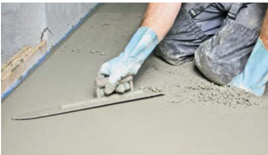
Glätten der Estrichoberfläche mit dem Estrichschwert.
