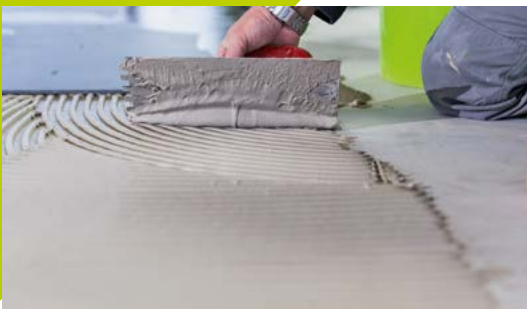
codex Power RX 4 Ultra ist hoch standfest und stabilisiert schwere Großformatfliesen zuverlässig ohne einzusinken.
